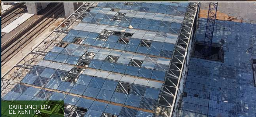
CENTRALE PHOTOVOLTAÏQUE DE 1 MWC POUR L'ALIMENTATION DE LA STATION DE RECHARGE DE BUS ELECTRIQUES
