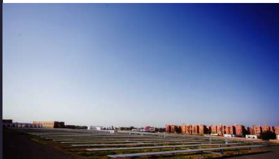
CENTRALE PV DE RECHARGE DE BUS ÉLECTRIQUES DE MARRAKECH
